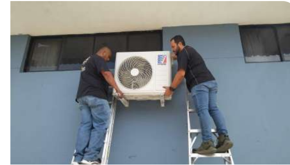
Mantenimiento de aires acondicionados
