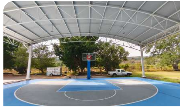
Construcción de domo y rehabilitación de espacio para usos múltiples en la Unidad Académica Preparatoria No. 8
