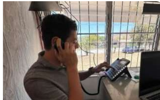
Instalación de líneas telefónicas
