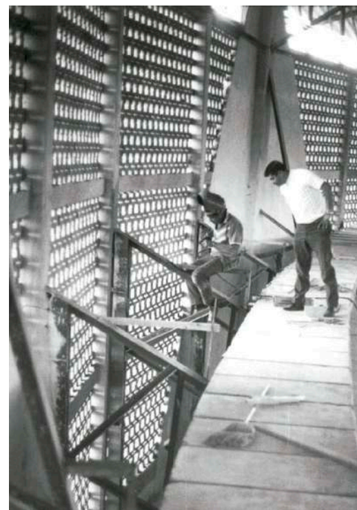
Ingeniero David Javier Ríos Ávalos, Director de Obras Públicas. Encargado de la construcción de la Ciudad de la Cultura, supervisando la soldadura de la estructura de acero del Mesón de los Deportes.
