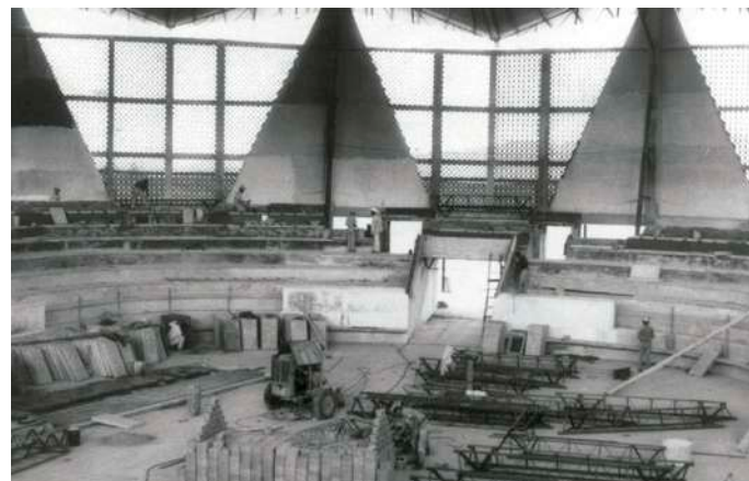
Vistas exterior e interior del Mesón de los Deportes.
